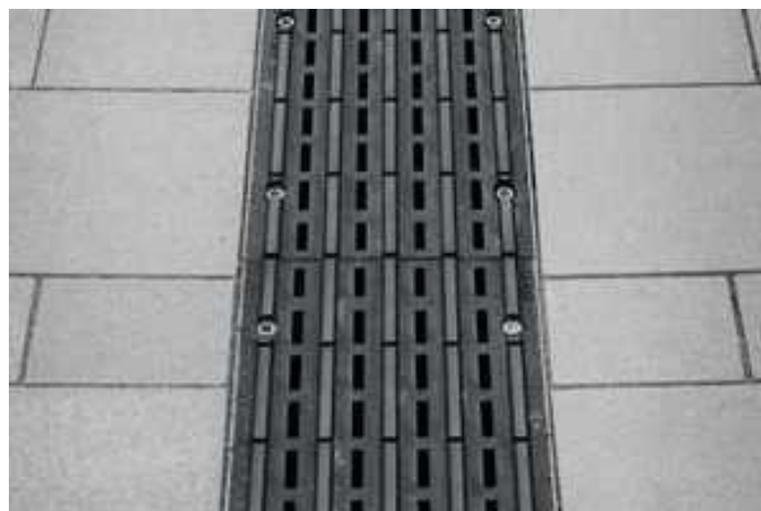
Fußgängerzone Bergisch Gladbach, integriertes Blindenleitsystem über den Abflussrinnen für Regenwasser
